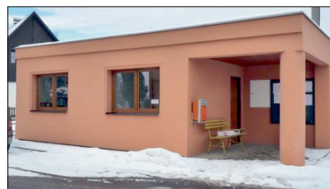
Místní knihovna v obci Vidonice na Jičínsku po rekonstrukci
